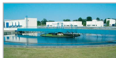
čistírna odpadních vod
